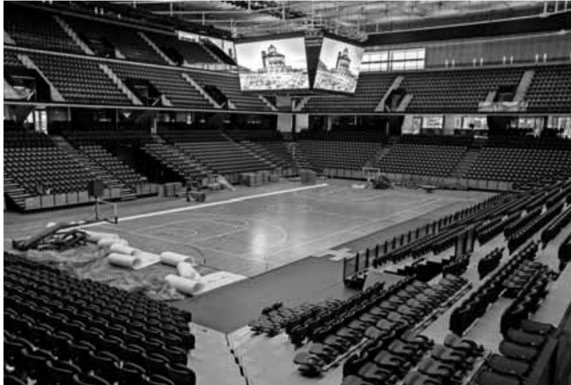
La pista de baloncesto, compuesta por 1.200 piezas de madera, se montó para las visitas guiadas. J. GARZARON
